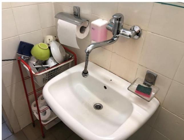
Slika 6.15: Posnetek umivalnika opremljenega z enoročno mešalno pipo
