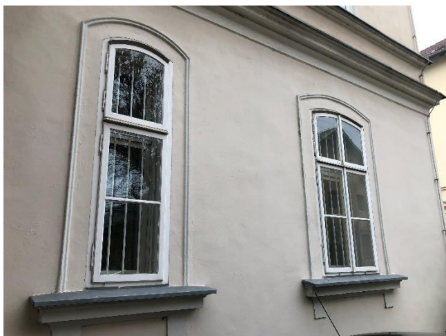
Slika 7.5: Posnetek lesenih škatlastih oken Vir: lastni vir.
