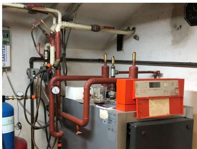
Slika 6.2: Posnetek razdelilnika ogrevalnega sistema Vir: lastni vir.
