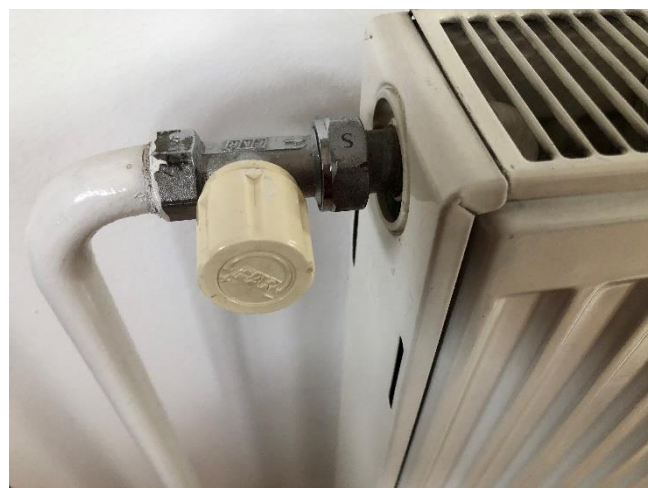
Slika 6.10: Posnetek ročnega radiatorskega ventila
