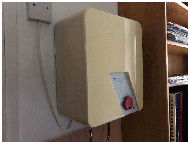
Slika 6.14: Posnetek električnega bojlerja Gorenje TEG 005-01N, prostornine 5 litrov Vir: lastni vir.
