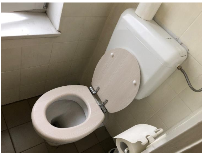
Slika 6.16: Posnetek WC školjke z nadomestnim splakovalnikom brez varčevalne tipke
