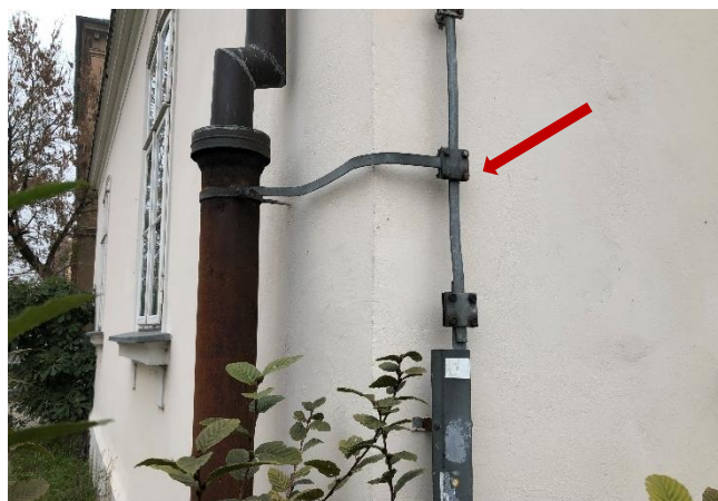
Slika 7.24: Posnetek detajla strelovodne instalacije Vir: lastni vir.
