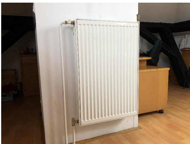
Slika 6.9: Posnetek ploščatega panelnega radiatorja brez vgrajenega termostatskega ventila
