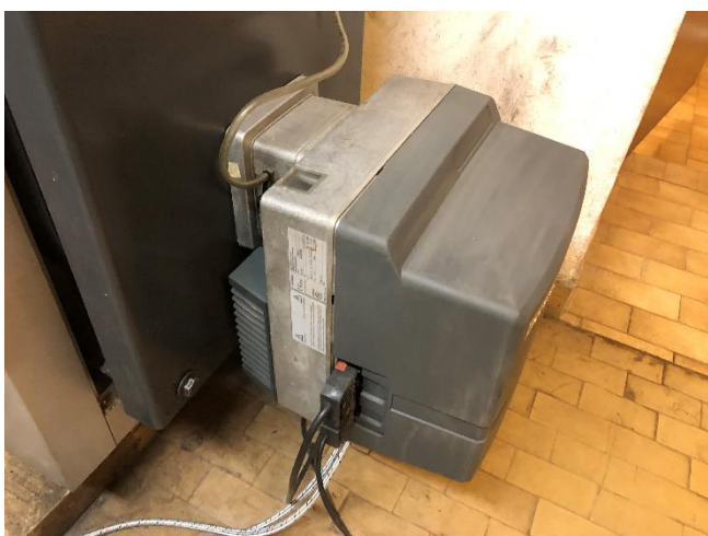
Slika 6.5: Posnetek gorilnika na kurilno olje, Weishaupt, tip WL20/1-C Z Vir: lastni vir.
