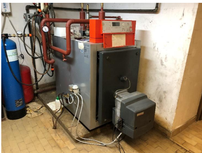
Slika 6.1: Posnetek kotla VISSMANN, tip VITOPLEX 200 Vir: lastni vir.
