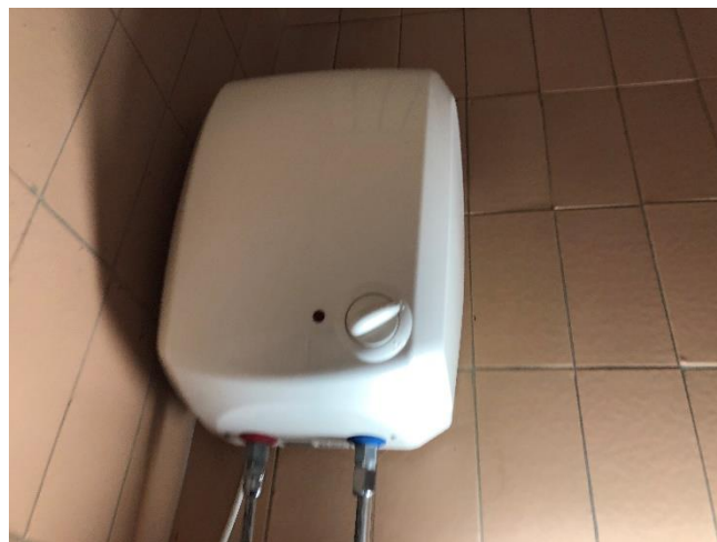
Slika 6.12: Posnetek električnega bojlerja Metalac EZV 5N MINI, prostornine 5 litrov Vir: lastni vir.
