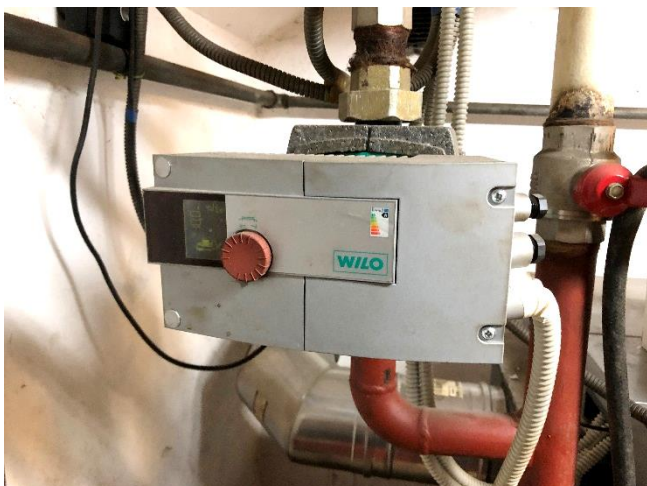
Slika 6.3: Posnetek obtočne črpalke WILO Stratos 30/1-12 s frekvenčno regulacijo delovanja Vir: lastni vir.
