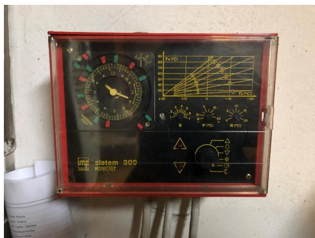
Slika 6.6: Posnetek regulatorja radiatorskega ogrevanja IMP Ljubljana, sistem 300 Vir: lastni vir.
