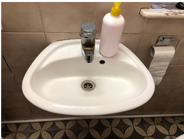
Slika 6.15: Posnetek umivalnika opremljenega z enoročno mešalno pipo
