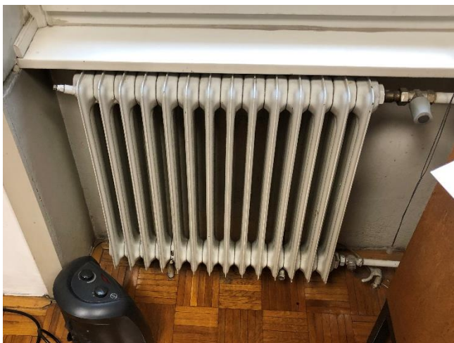
Slika 6.7: Posnetek rebrastega radiatorja brez vgrajenega termostatskega ventila
