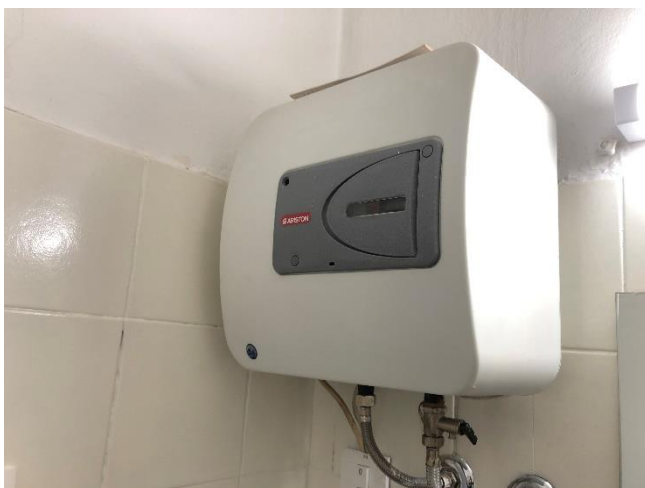
Slika 6.13: Posnetek električnega bojlerja Ariston, prostornine 10 litrov Vir: lastni vir.
