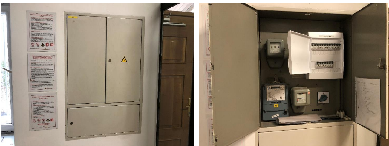
Slika 6.17: Posnetek glavne elektro omare z merilno garnituro, razdelilnik R-P
