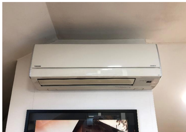
Slika 7.22: Posnetek notranje enote split klimatske naprave Vir: lastni vir.
