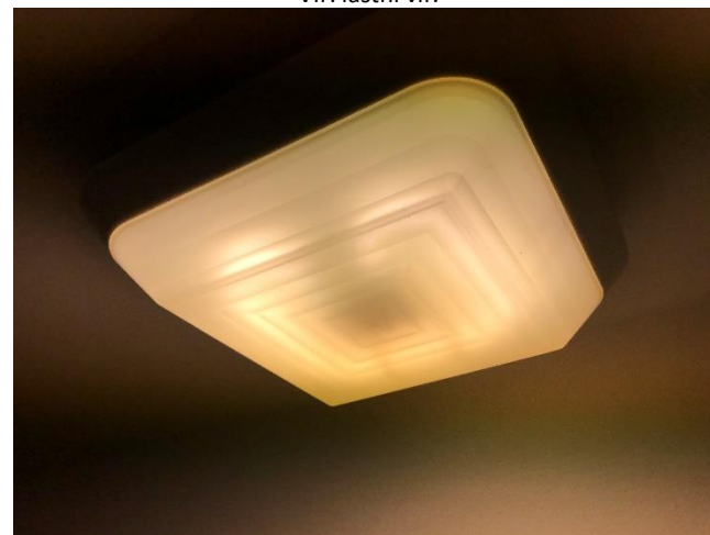
Slika 7.17: Posnetek razsvetljave - kompaktna fluorescentna sijalka
