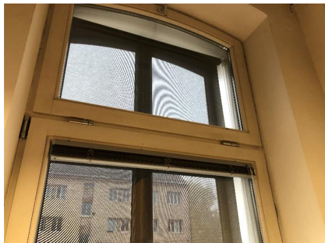
Slika 7.8: Posnetek senčila (rolo) med notranjim in zunanjim krilom lesenega okna Vir: lastni vir.
