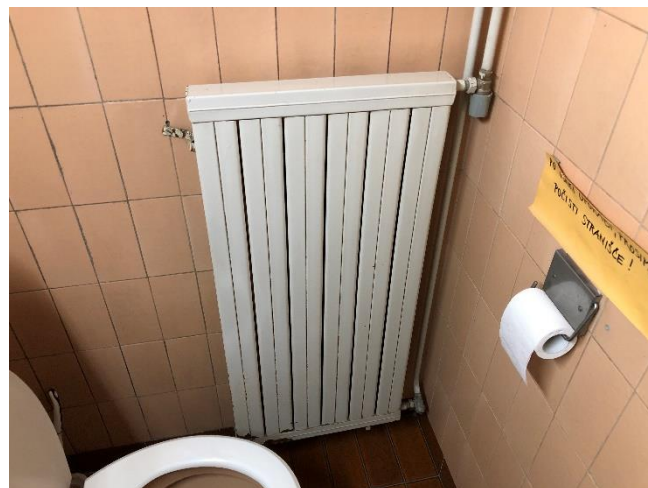
Slika 6.8: Posnetek aluminijastega radiatorja brez vgrajenega termostatskega ventila
