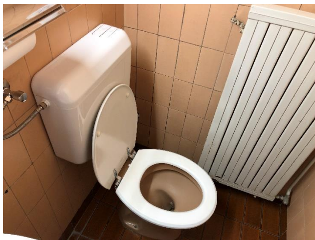
Slika 6.16: Posnetek WC školjke z nadomestnim splakovalnikom brez varčevalne tipke
