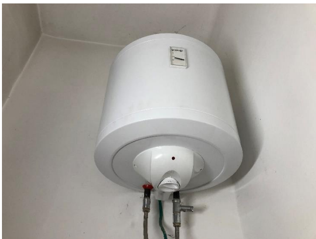
Slika 6.11: Posnetek električnega bojlerja Gorenje TGR30NG, prostornine 30 litrov Vir: lastni vir.
